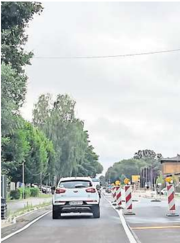
Seit Mittwoch (22. Juli) regelt eine Baustellenampel den B5-Verkehr am Bahnhof Wusterhausen.
