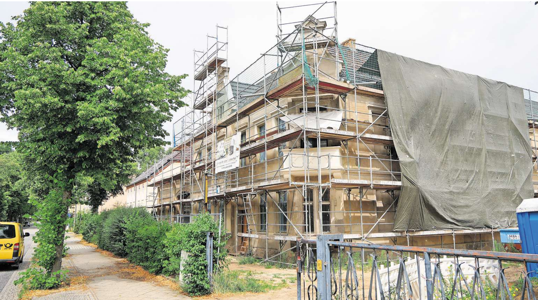
Die Firma Sunbender Immobilien saniert in Rheinsberg das alte Haus Wittkopf in der Berliner Straße 44. Dort könnte eine Arztpraxis einziehen.
