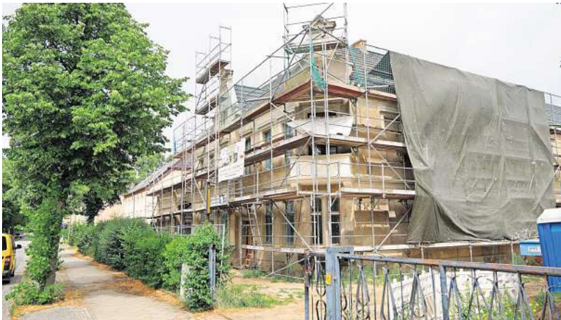
Die Firma Sunbender Immobilien saniert in Rheinsberg das alte Haus Wittkopf in der Berliner Straße 44. FOTO: ALEXANDER BECKMANN
